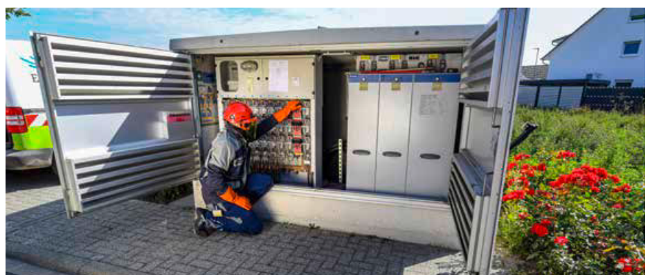
Durch Erfahrung gut: ED Netze betreibt 4.000 eigene Trafo-Stationen und eine steigende Anzahl auch für Kunden.
